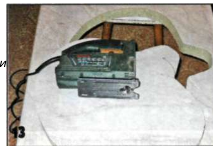
13 Отверстие в столешнице под раковину вырезал электролобзиком по шаблону.
