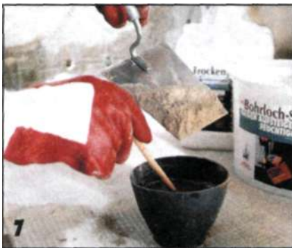
Чтобы заглушить отверстия, готовят из сухой цементной смеси ремонтный раствор средней консистенции.
