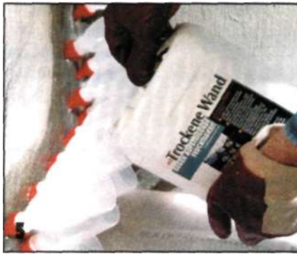
Привернув к удлиненной воронке остроконечную насадку, вставляют ее до упора в отверстие и заполняют воронку до половины изолирующим составом.
