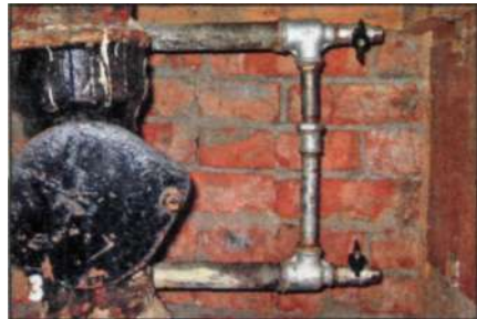
Сантехники демонтировали старый полотенцесушитель. Подключать новый теперь можно, не перекрывая воду во всем подъезде.
