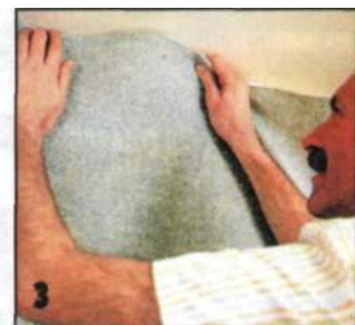
3 Обои натягивают, выравнивают. Клей наносят только на стену, и прижимают к стене.
