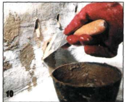
Шпателем затирают выступивший раствор обратно в отверстия заподлицо с поверхностью стены.
