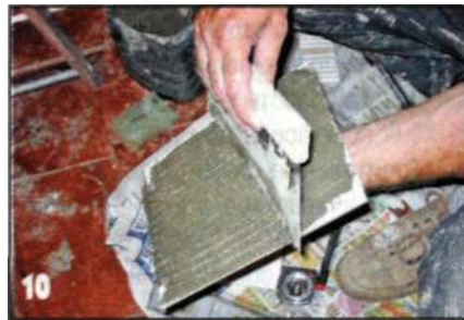
10 Плитку укладывал на клей, нанося его зубчатым шпателем.
