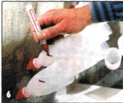
Отмечают маркером на воронке уровень состава. Операция занимает от 6 до 14 дней (когда уровень перестает понижаться без учета доливаемого состава).
