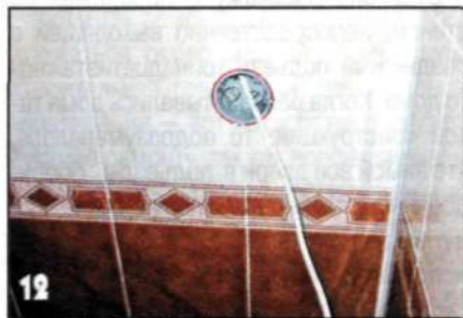
12 Заранее установил коробку для розетки под стиральную машину и вывел в нее электрический кабель.
