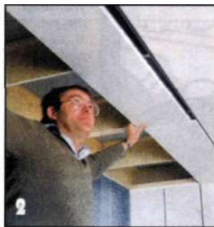
Сначала обшивают стену, затем — потолок. Швы между панелями обшивки стен и потолка должны совпадать.
