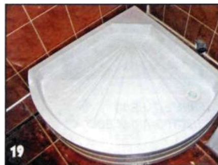
После завершения строительных работ и монтажа поддона можно устанавливать душевую кабину.
