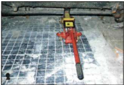
Ломать — не строить. Но до начала ремонтных работ желательно освободить помещение от строительного мусора и ненужного оборудования. Стронуть чугунную ванну с места помог автомобильный домкрат.
