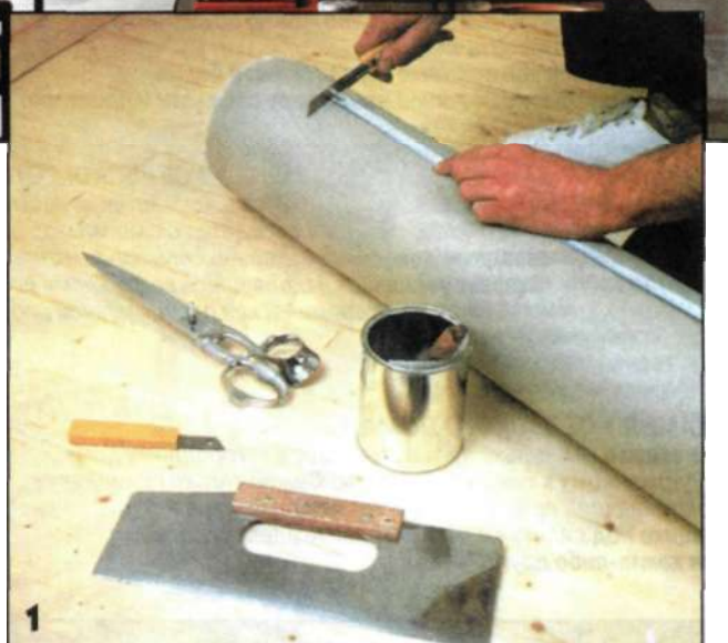
1 Перед оклейкой весь рулон обрезают по высоте помещения.
