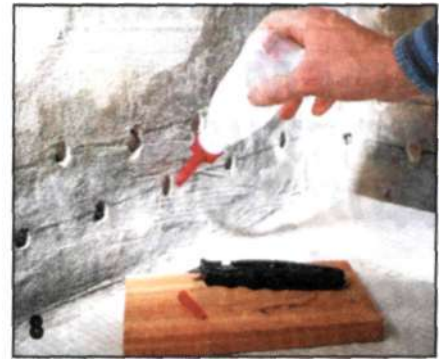
Заполнять отверстия раствором удобно с помощью той же воронки, обрезав ее остроконечную насадку на 3-5 см.
