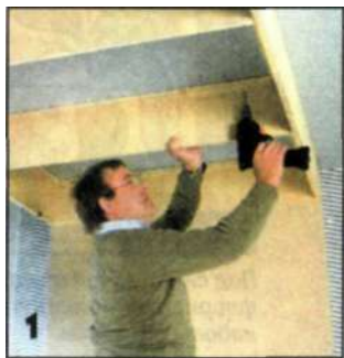
Обрешетку для подвески потолочных панелей крепят к несущим брускам, надежно привинченными шурупами к потолку.
